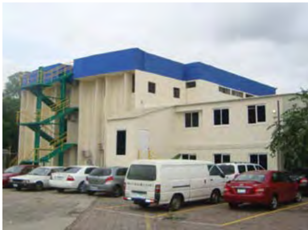
Nuevas instalaciones, oficina fiscal de Soyapango.
